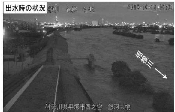
令和元年台風第 19 号 相模川（平塚市）国直轄管理区間
