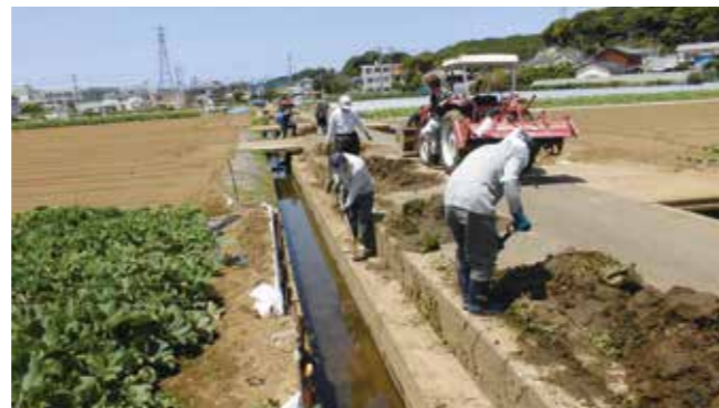
地域ぐるみで実施する水路の泥上げ作業(三浦市)
