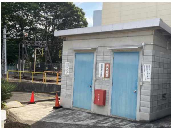
写真 2 - 1 - (1) 危険物屋内貯蔵所
