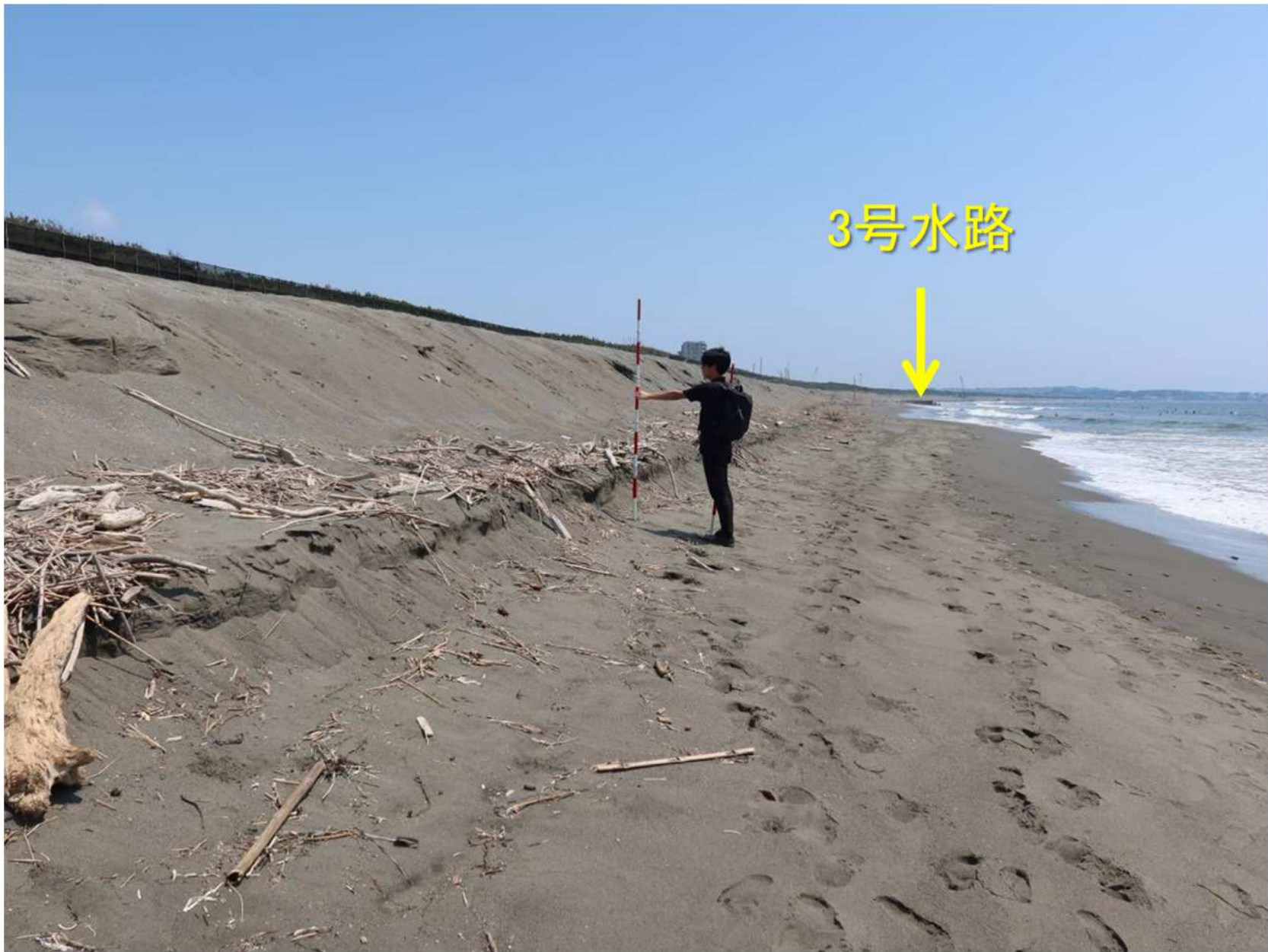
写真-21 盛り土養浜の基部で進む浜崖侵食
