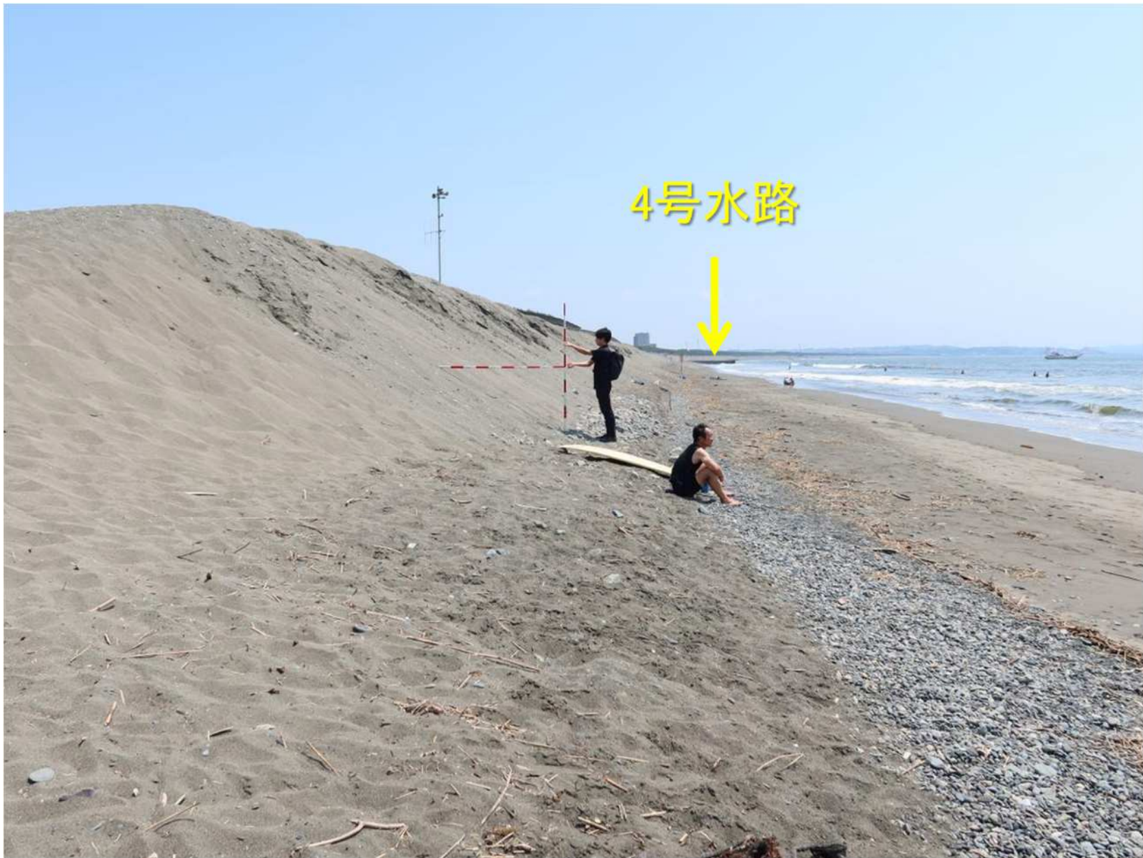
写真-12 盛り土の浜崖侵食が始まる地点の海浜状況
