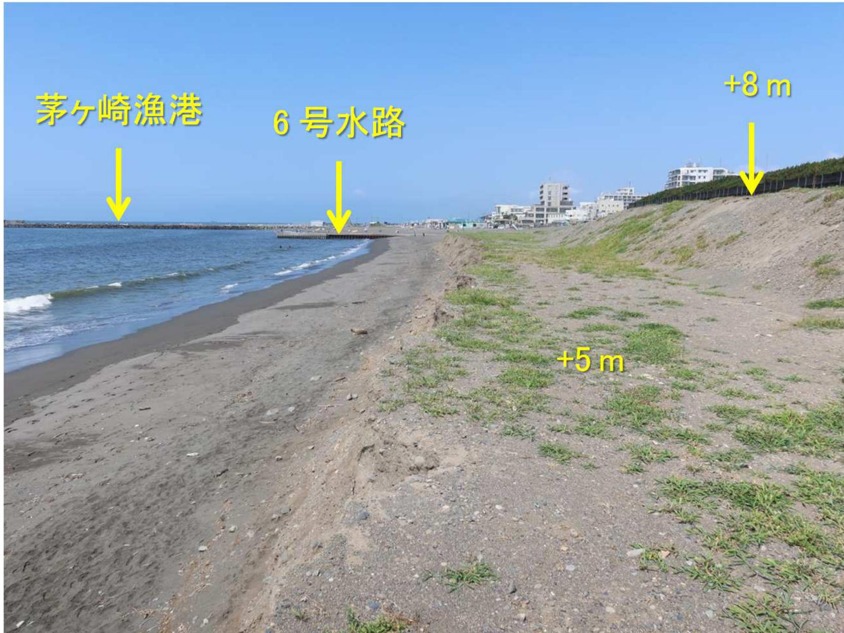
写真-4 盛り土上から西向きに望む 高さ+5 mの天端は+8mから下げられている.
