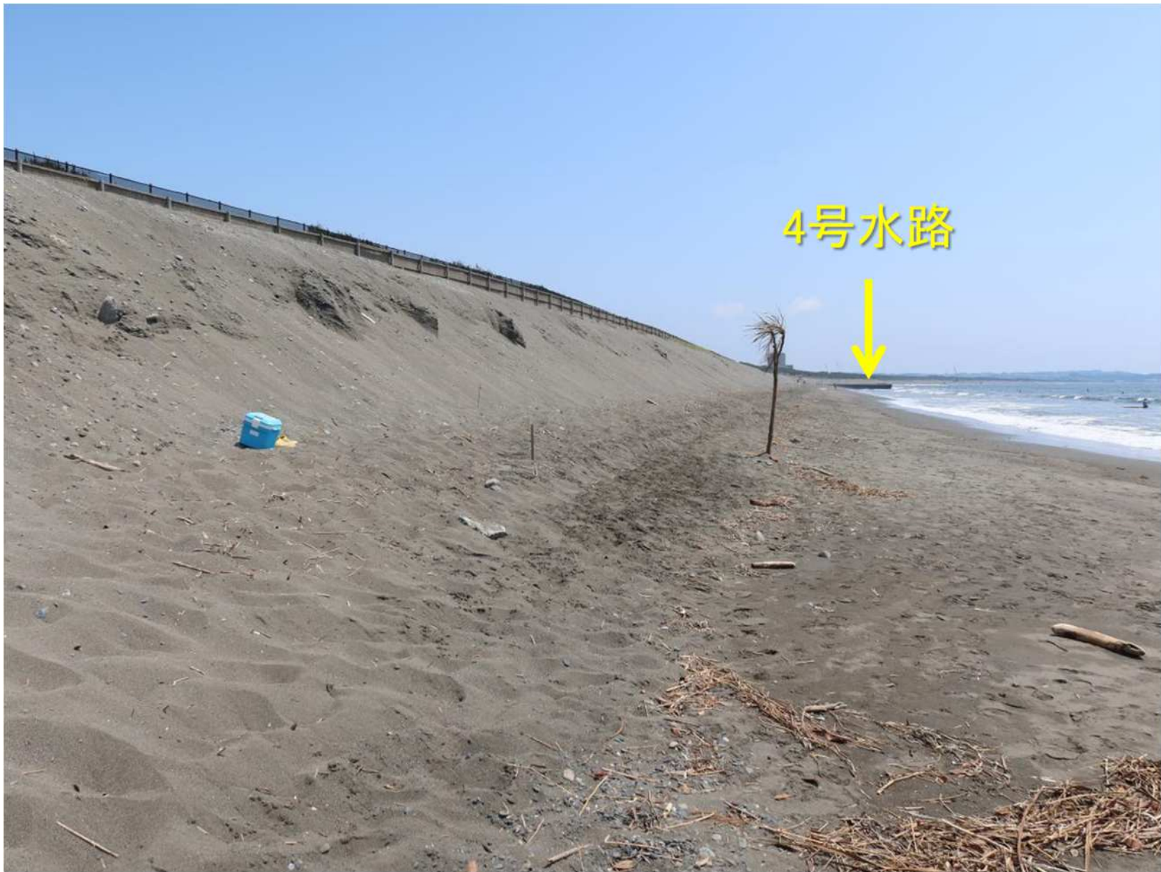
写真-15 一連の浜崖形成区域 斜面は安定化しつつある.
