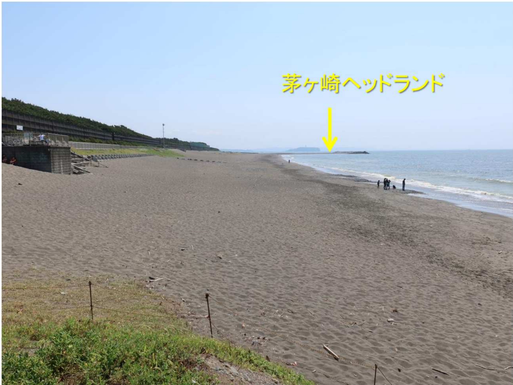
写真-5 養浜砂が堆積した中海岸地先東部 自然海浜と変わらない.
