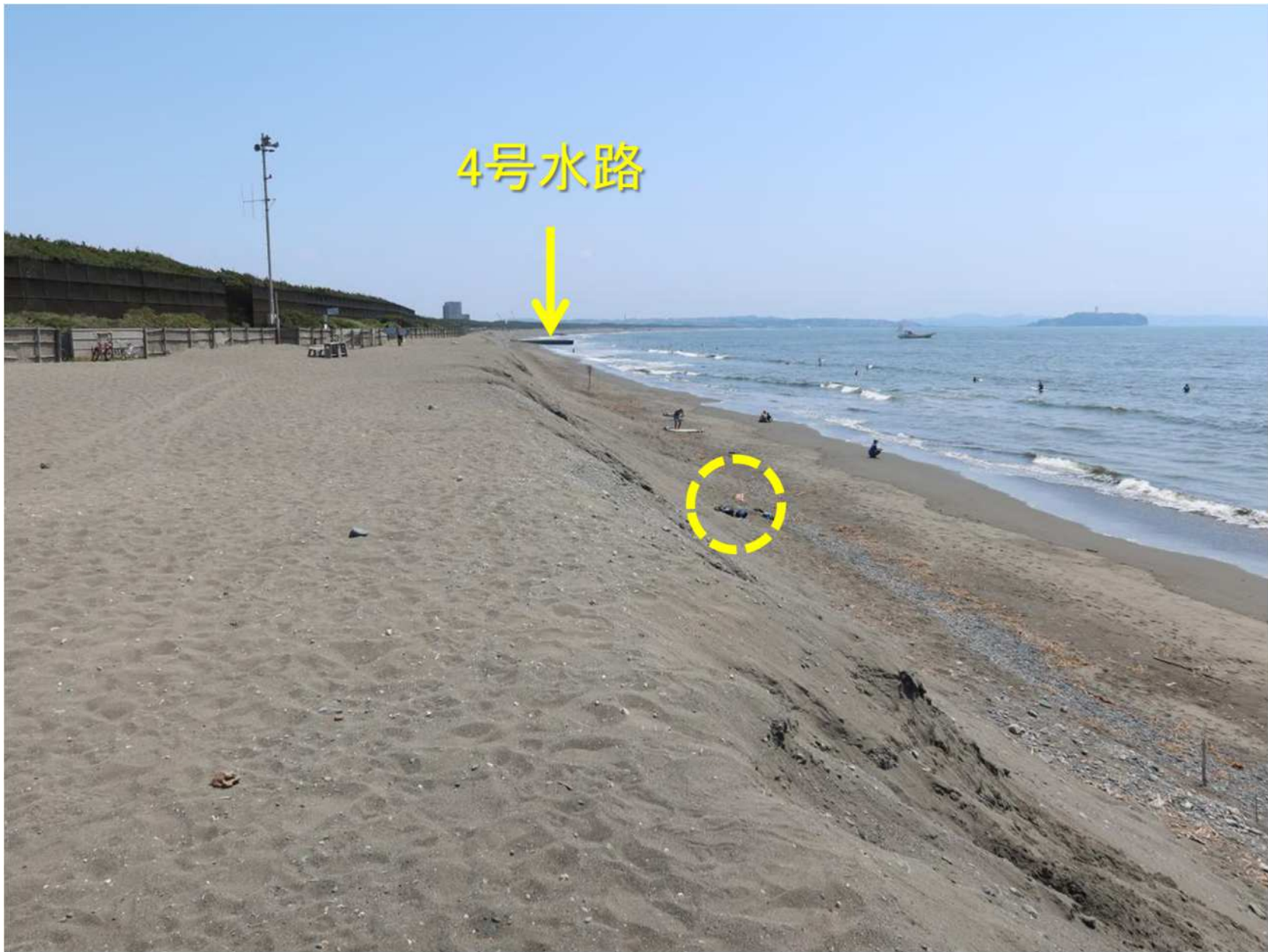
写真-13 盛り土上から4号水路方面を望む
