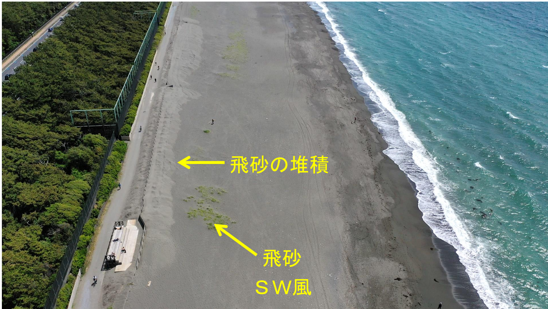
写真-4 広がった海浜からの飛砂による自転車道への堆砂
