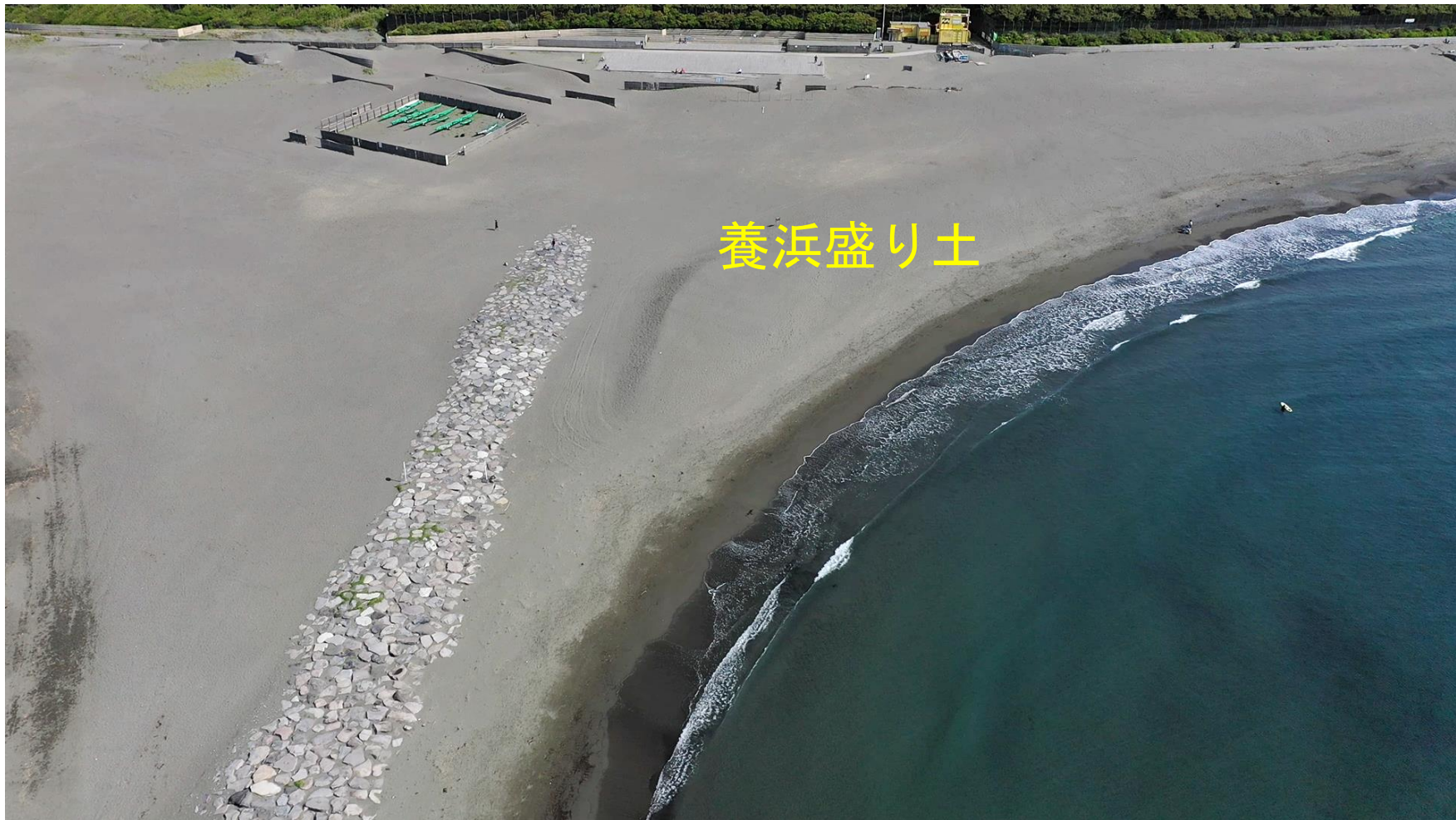
写真-6 茅ヶ崎ヘッドランドの東側側面にそのまま残された養浜盛り土
