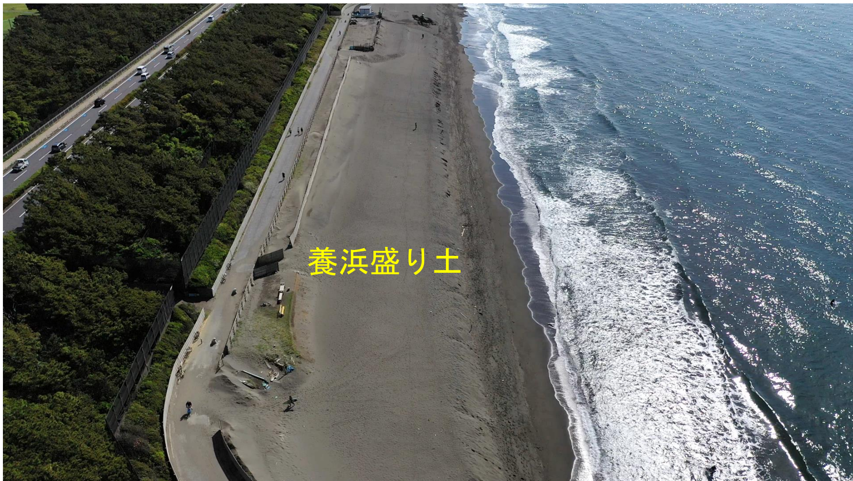
写真-11 白浜地区の4号水路と3号水路の間の養浜盛り土
