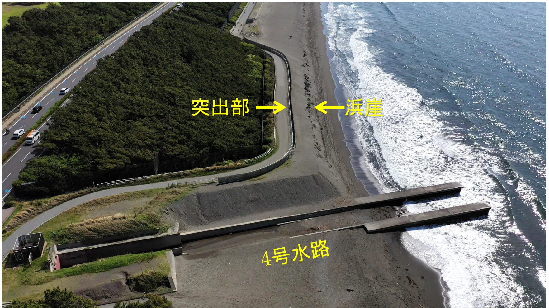
写真-10 4号水路周辺の斜め画像
