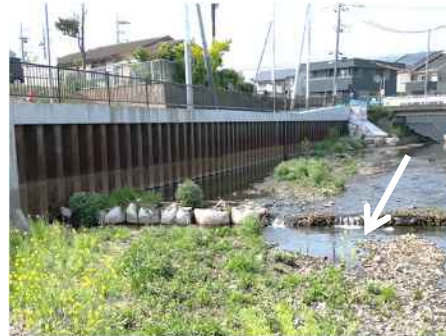
国府橋下流（整備済箇所）
