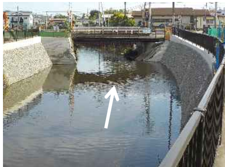
国府橋上流（整備済箇所）
