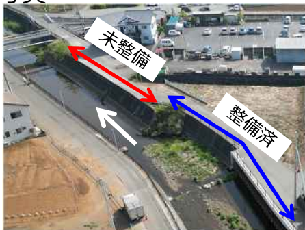
馬場橋上流（未整備箇所）
