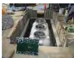
一般家庭への浄化槽設置
