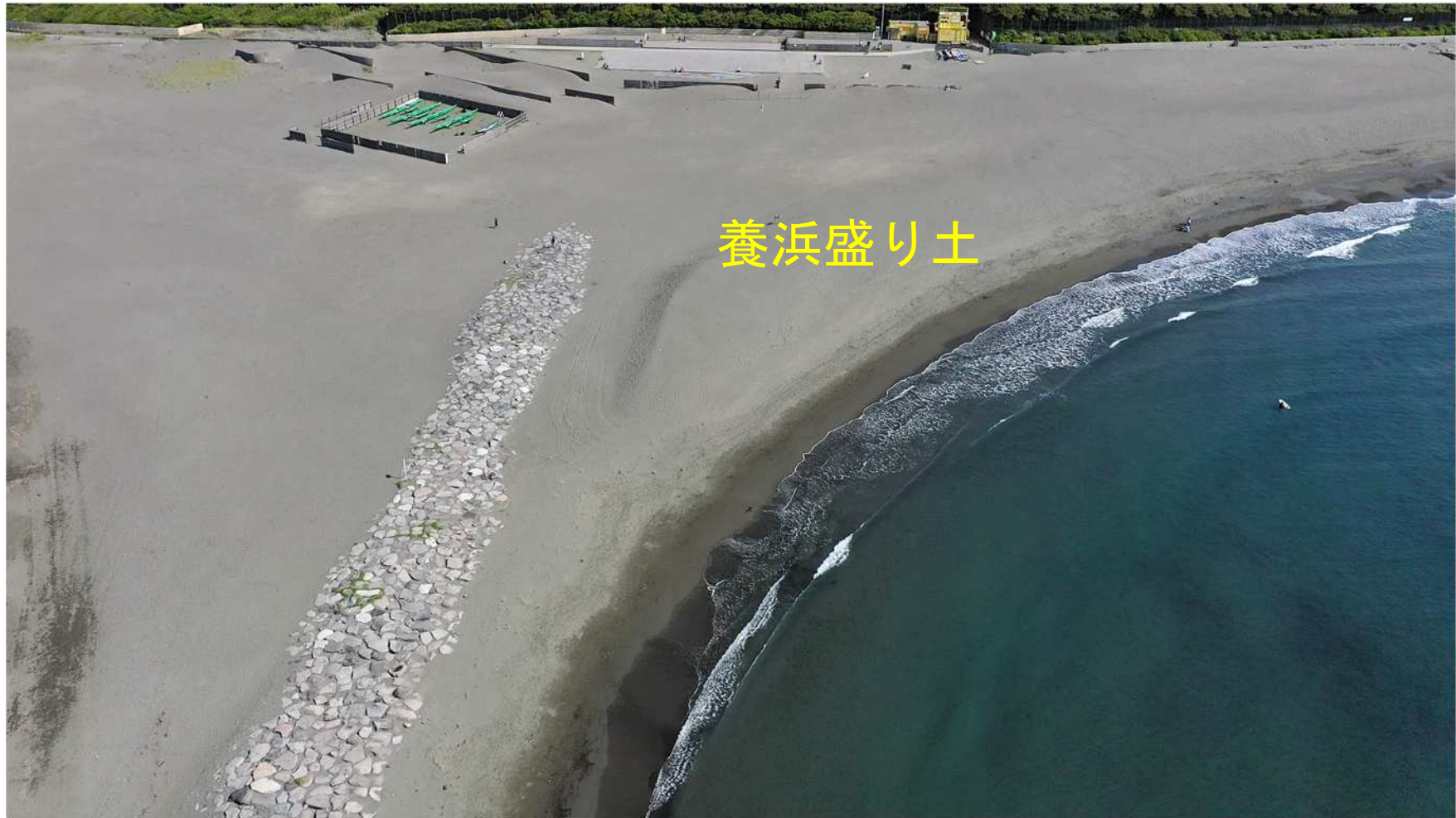
写真-6 茅ヶ崎ヘッドランドの東側側面にそのまま残された養浜盛り土
