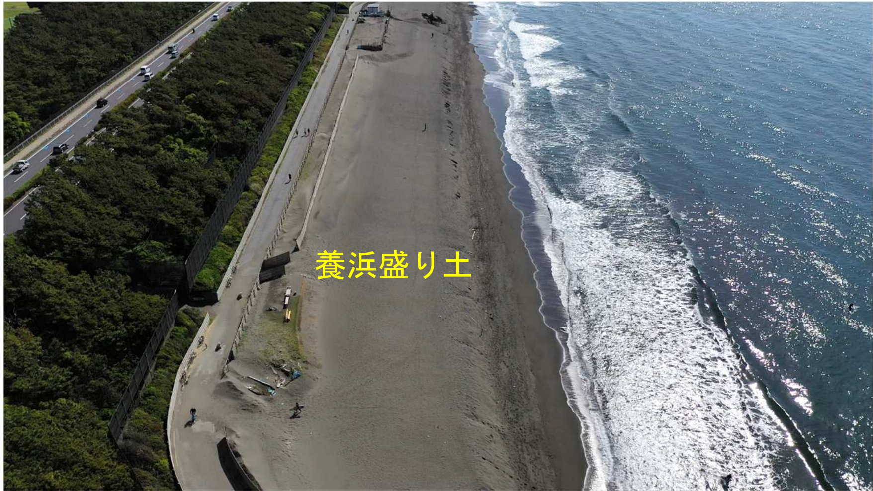
写真-11 白浜地区の4号水路と3号水路の間の養浜盛り土
