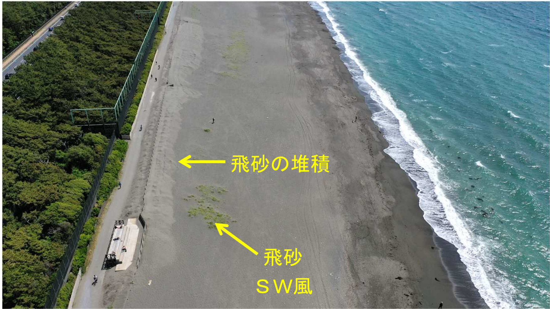
写真-4 広がった海浜からの飛砂による自転車道への堆砂
