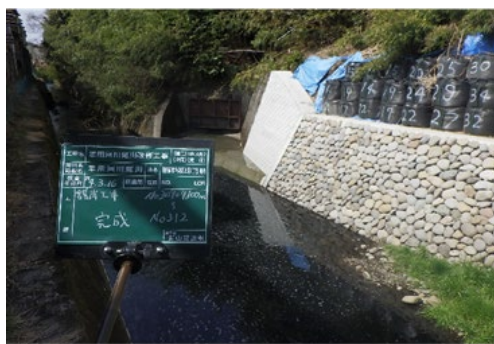
自然石を使用した護岸
