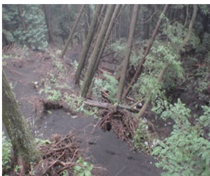
崩壊した林地
