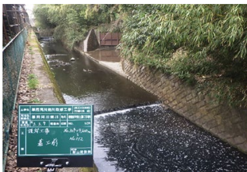
コンクリートの護岸
