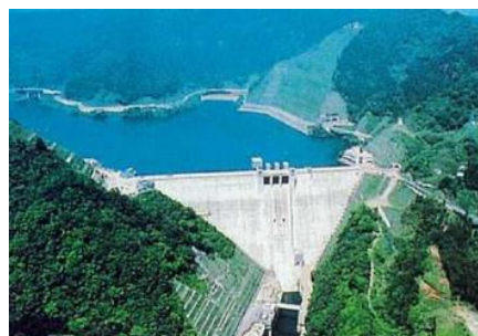
宮ヶ瀬ダムと宮ヶ瀬湖（平成13年完成）
