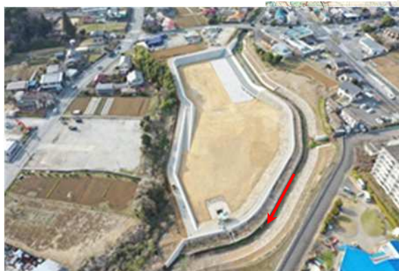
上流区間 遊水地整備 本体工事完成 (緑区川尻他)
