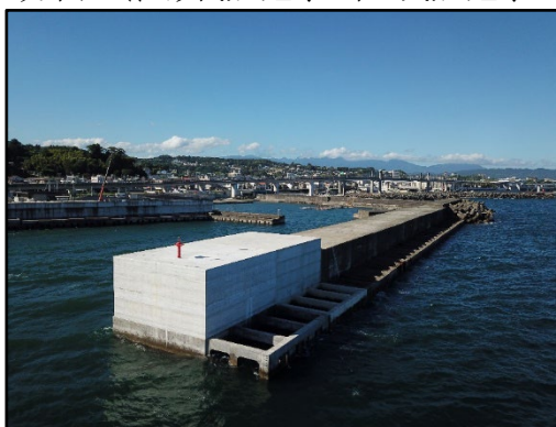
防波堤の延伸工事（小田原漁港）
