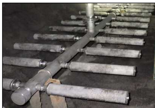
散気装置の改築更新（相模川流域下水道右岸処理場）
