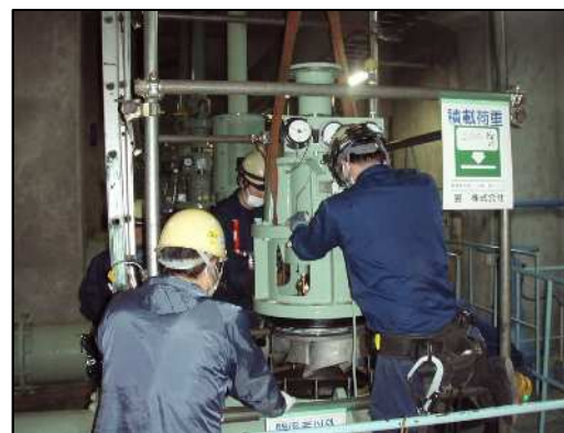
機械設備の修繕の様子
