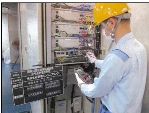
電気設備の点検の様子
