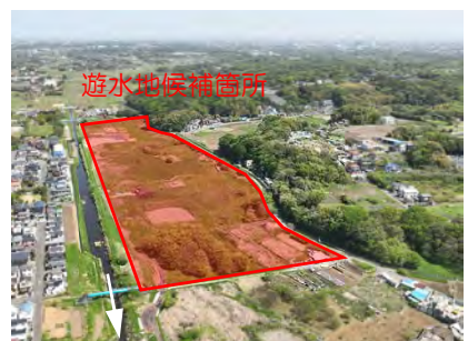
一ツ橋上流遊水地整備箇所
