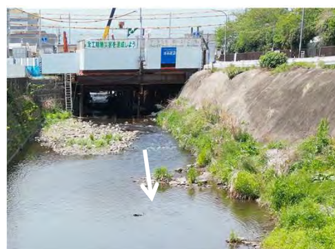
小田急線橋梁下流左岸（整備予定箇所）
