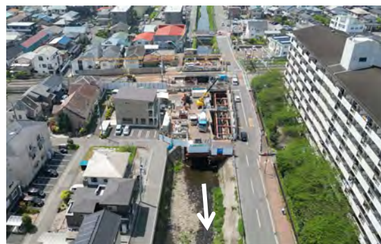
小田急線橋梁（下流側）
