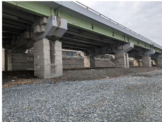
令和5年6月（階段撤去実施後）
