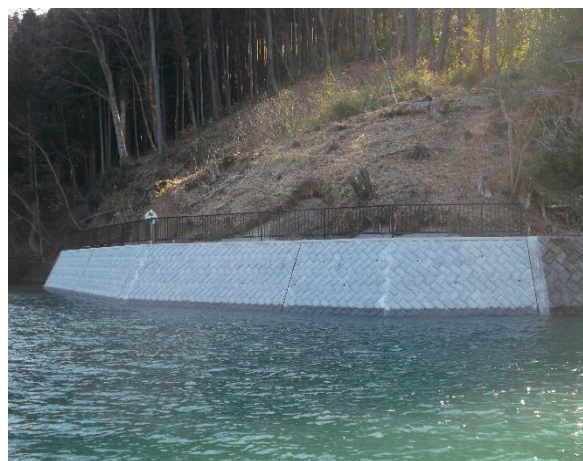
相模貯水池の崩落防止対策
