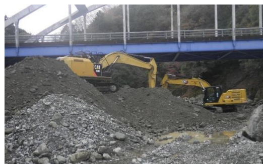
道志調整池のしゅんせつ作業 (バックホウによる陸上からの掘削作業)
