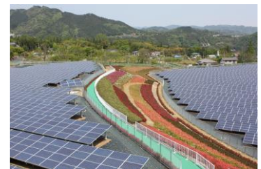
愛川太陽光発電所のつつじ庭園
