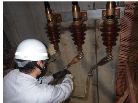
水力発電所の劣化診断（城山発電所）
