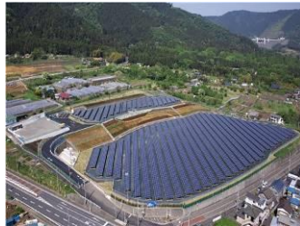
愛川太陽光発電所
