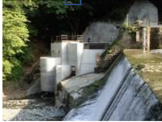
早戸川発電所
