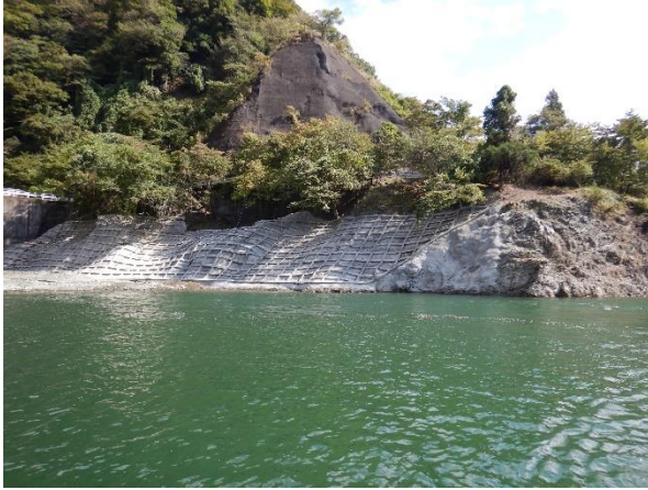
三保貯水池の崩落防止対策
