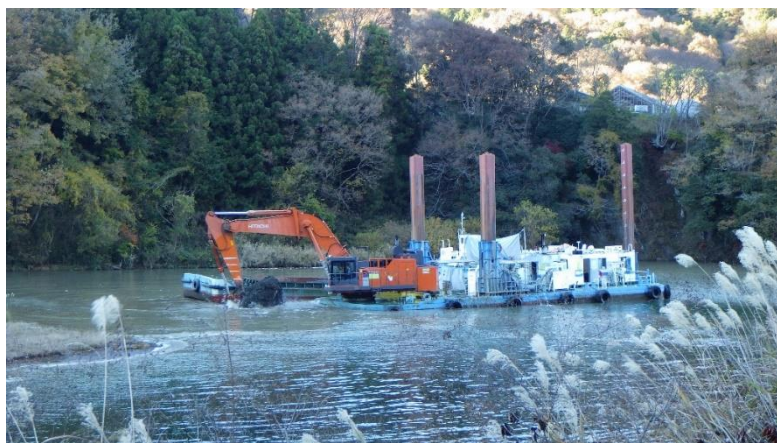
相模貯水池のしゅんせつ作業 (しゅんせつ船による湖面からの掘削作業)
