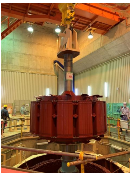
水力発電所のオーバーホール (愛川第1発電所)
