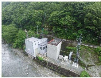
玄倉第1発電所
