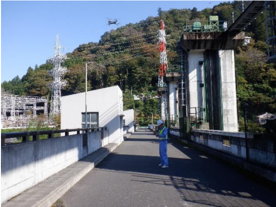
ドローンによるダムの点検・調査
