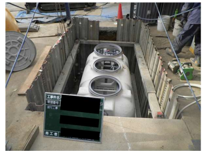
(一般家庭への浄化槽設置(相模原市))
