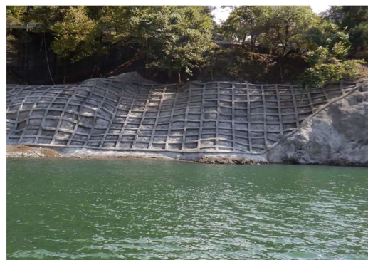
(丹沢湖周辺崩落防止工事)
