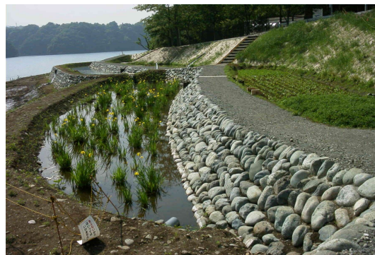
(三井地区植物浄化施設)
