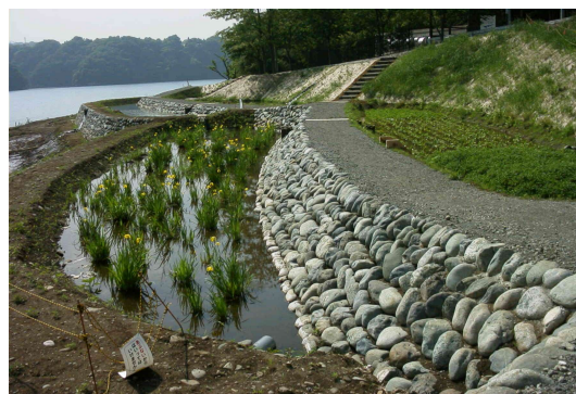
(三井地区植物浄化施設)
