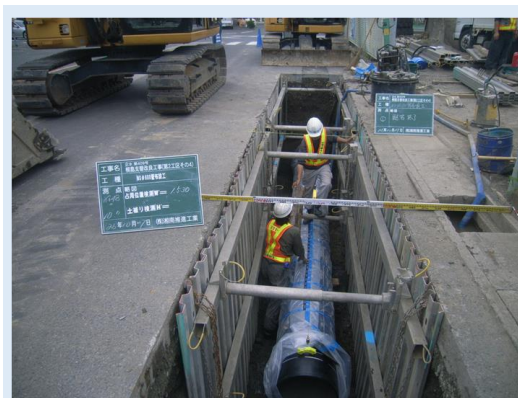
【老朽管更新工事（企業庁）】
