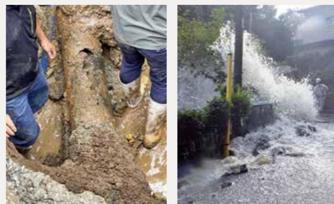
老朽化により破損した水道管
