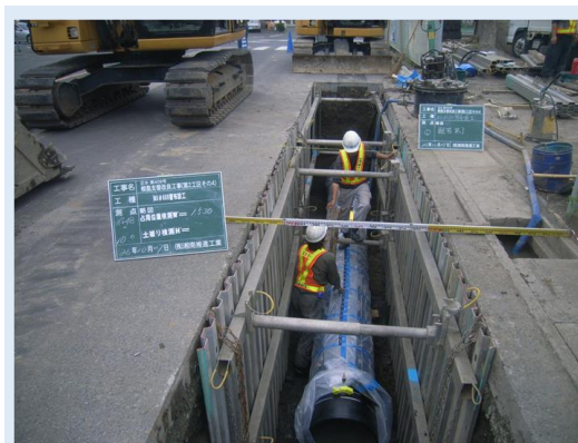
【老朽管更新工事（企業庁）】
