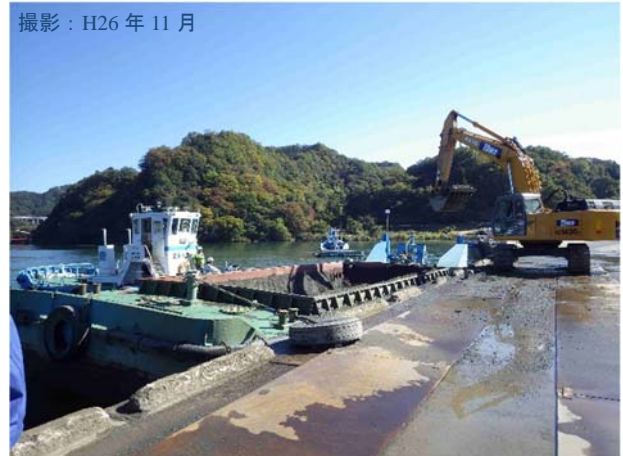
写真 2.2.2 相模ダム浚渫の実施状況
