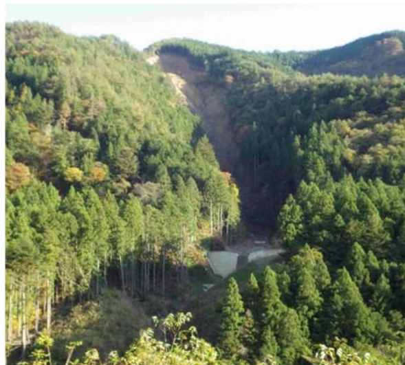
写真 2.2.1 平成 23 年台風 12 号で生じた深層崩壊（山梨県大月市）
