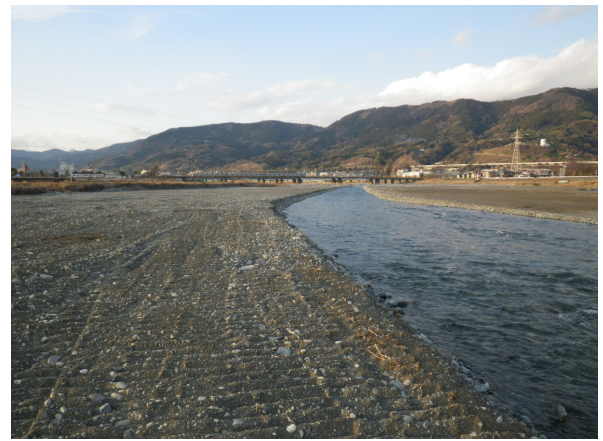
施工後（平成28年1月）
