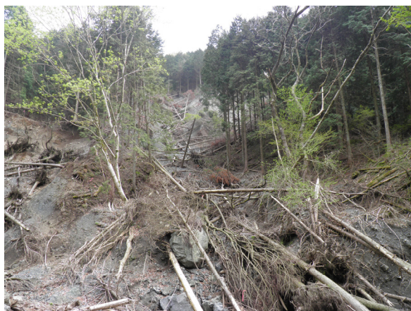
施工前（平成24年4月）
