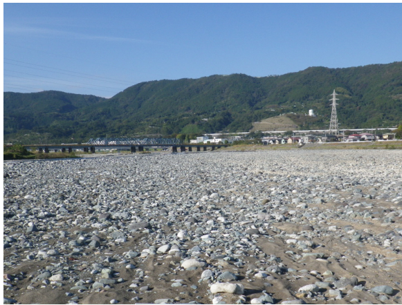
施工前（平成27年10月）
