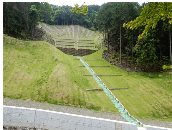
施工後（平成28年6月）
