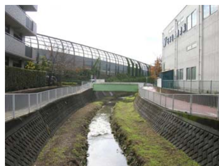
⑨名瀬川羽沢橋付近
