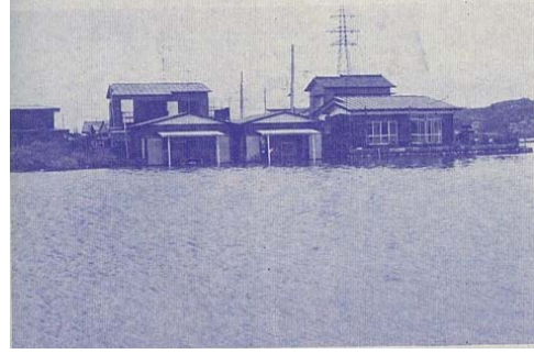
昭和 49 年 7 月台風第 8 号（藤沢市立石付近）
