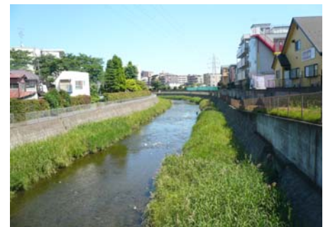
③境川幸延寺橋付近
