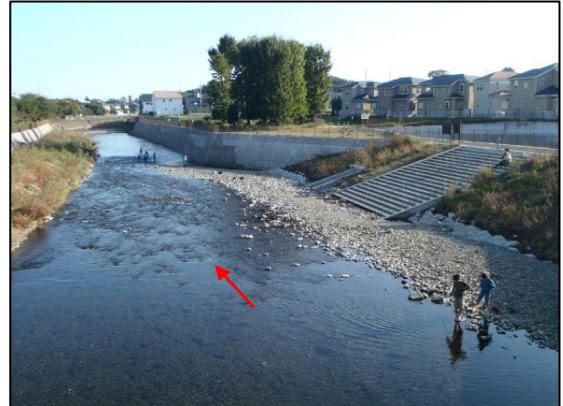
写真 4-2 親水護岸の状況 (鶴間一号橋下流)
