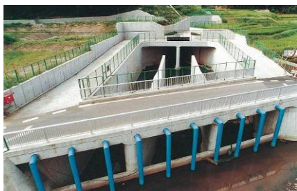
三沢川分水路流入口(完成当時)
