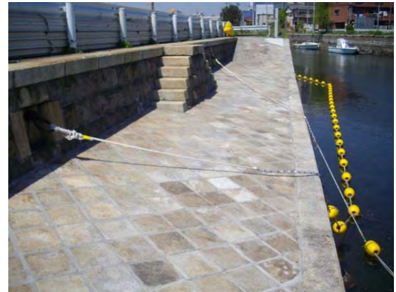
図 10 堀割川天神橋上流の荷揚場・石積み階段
