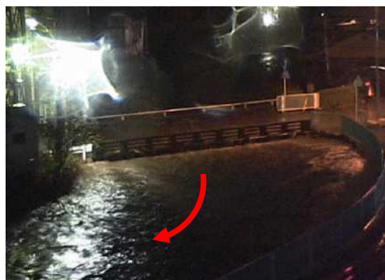
平成25年の浸水状況（内輪橋）
