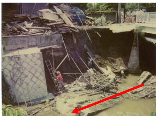
平成2年の洗掘被害（塩海橋下流）
