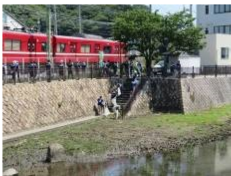
写真 2-2 (左) 階段護岸(下田橋下流)
