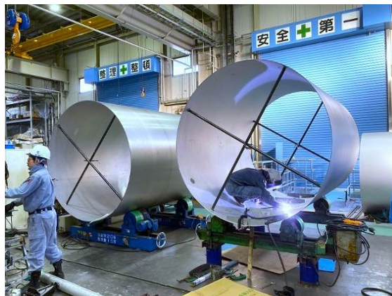
作業風景：ステンレス製丸タンクの製作
