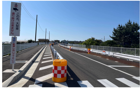
写真②：暫定供用済み区間の状況
