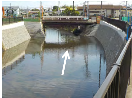
国府橋上流（整備済箇所）
