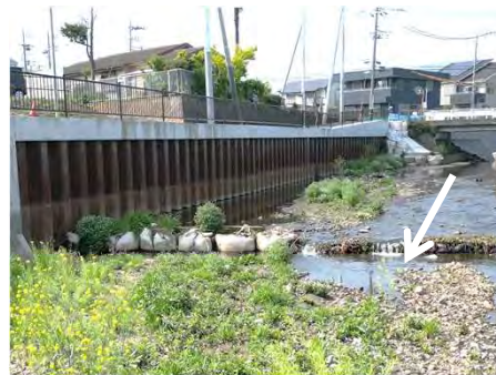
国府橋下流（整備済箇所）
