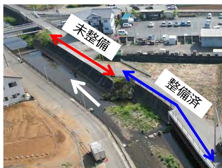
馬場橋上流（未整備箇所）
