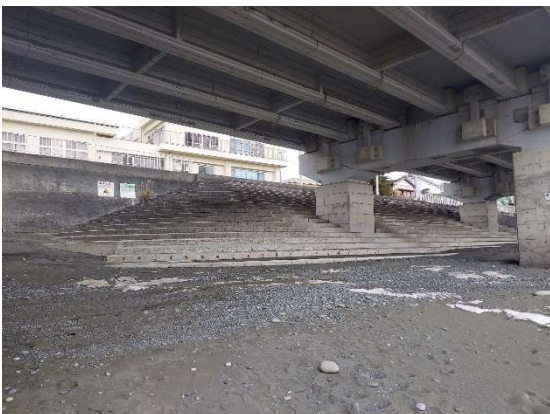
令和5年6月（階段撤去実施前）
