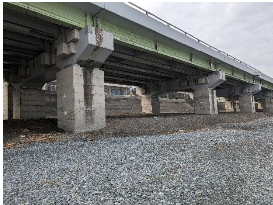
令和5年6月（階段撤去実施後）
