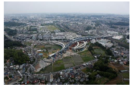
高速横浜環状南線 栄インターチェンジ・ジャンクション
