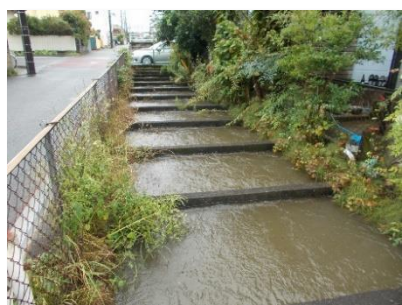
出水時の状況
