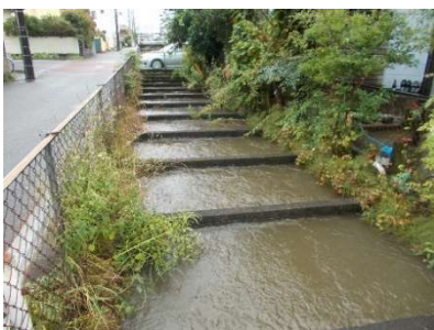
出水時の状況
