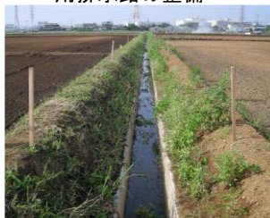
用排水路の整備
