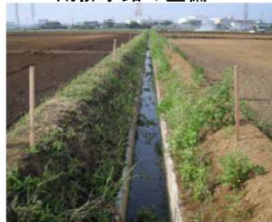
用排水路の整備
