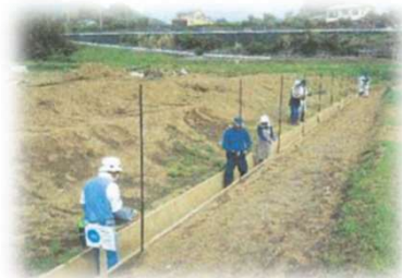
鳥獣害防止柵の設置活動 (中山間地域等直接支払交付金)
