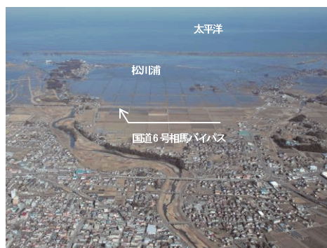
防潮堤の役割を果たし津波浸水を防止した 国道6号相馬バイパスの盛土区間
