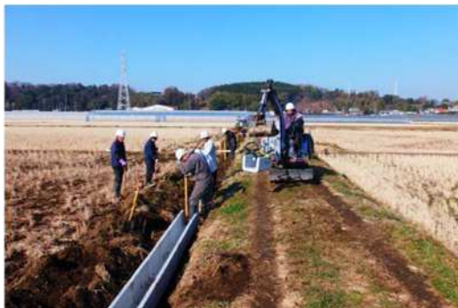
老朽化水路の更新
