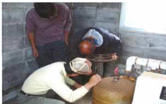
畑かん用ポンプの軽微な補修
