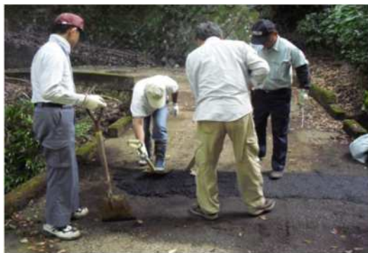
農道の維持補修
