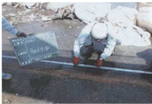
取水門の補修
