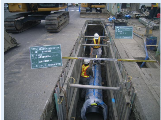
【老朽管更新工事（県企業庁）】
