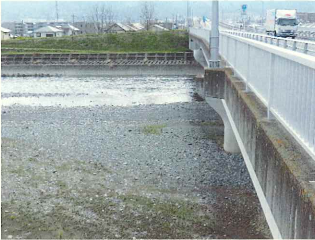
足柄紫水大橋橋脚下流端 (アユルアー区間上流端)
