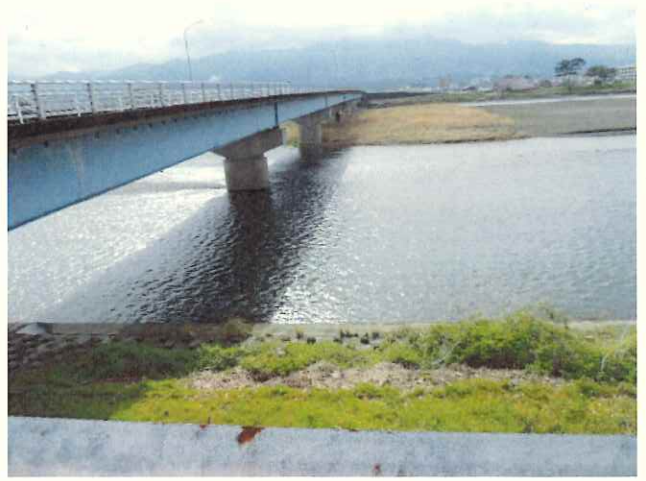
富士道橋橋脚上流端 (アユルアー区間下流端)
