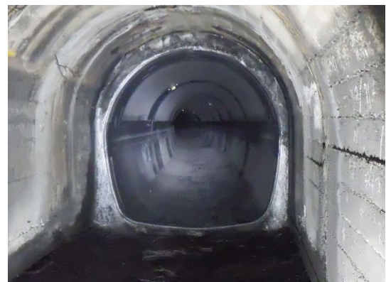
改修中の農業用水路（水路トンネル）
