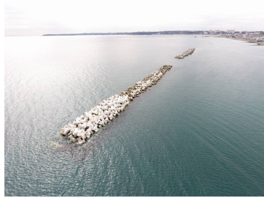
離岸堤（北下浦漁港海岸）
