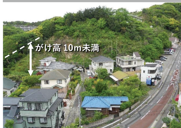
沼間 2 丁目 C 地区（逗子市）：R6工事实施
