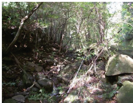
溪流荒廃状況
