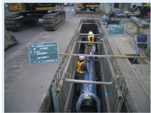
【老朽管更新工事（県企業庁）】
