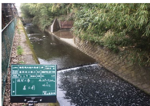
コンクリートの護岸
