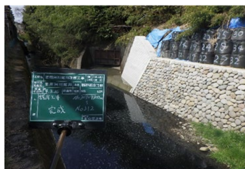
自然石を使用した護岸
