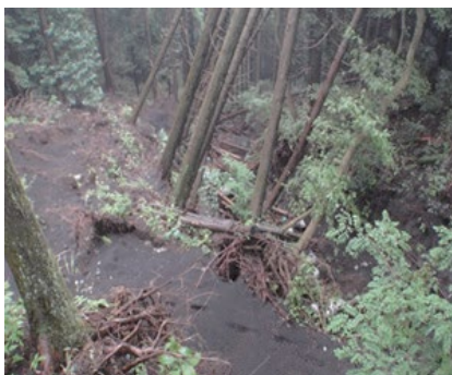
崩壊した林地
