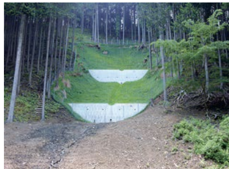
土木的工法を使用した取組（土留め工）
