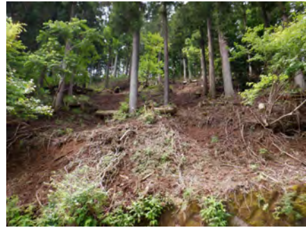
中標高域の自然林の土壌保全対策
