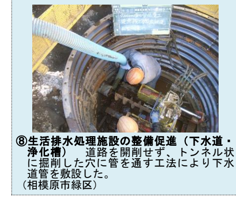
⑧生活排水処理施設の整備促進（下水道・浄化槽） 道路を開削せず、トンネル状に掘削した穴に管を通す工法により下水道管を敷設した。（相模原市緑区）
