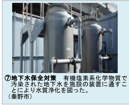
⑦地下水保全対策 有機塩素系化学物質で汚染された地下水を施設の装置に通すことにより水質浄化を図った。（秦野市）
